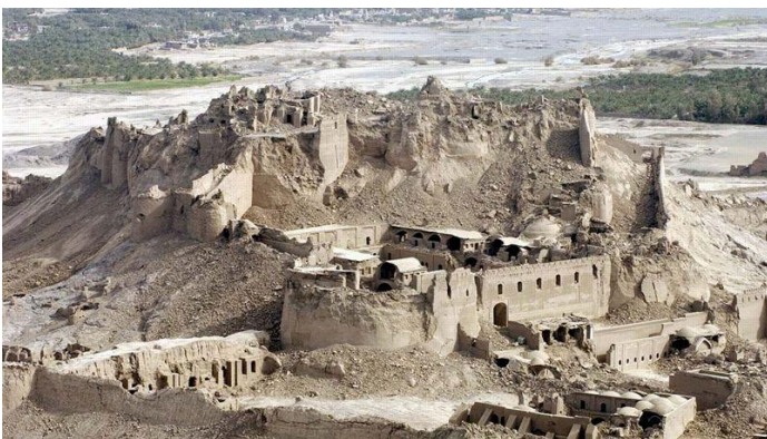
Citadelle historique d'Arg-e après le séisme
