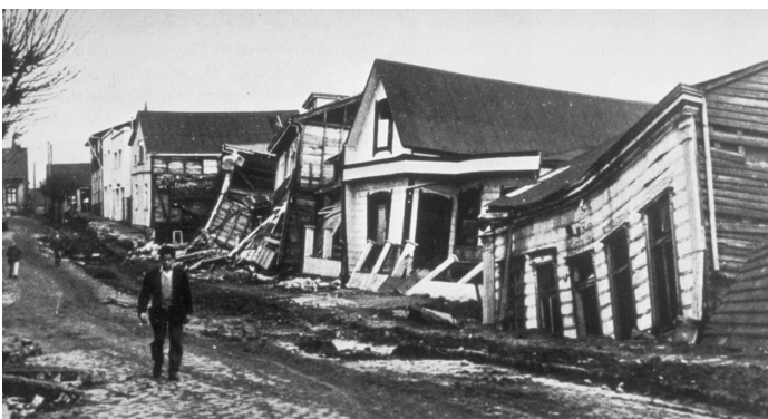
Rue de Valdivia après le tremblement de terre
