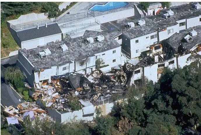
Dégâts dans la banlieue de Los Angeles
