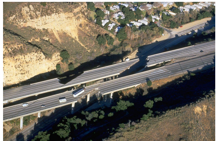
Pont autoroutier effondré
