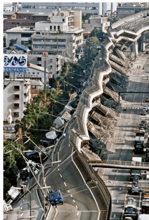
Dégâts de la ville de Kobé
