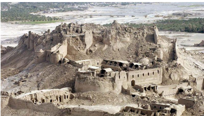
Citadelle historique d'Arg-e après le séisme
