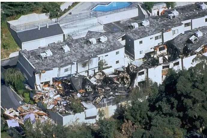
Dégâts dans la banlieue de Los Angeles
