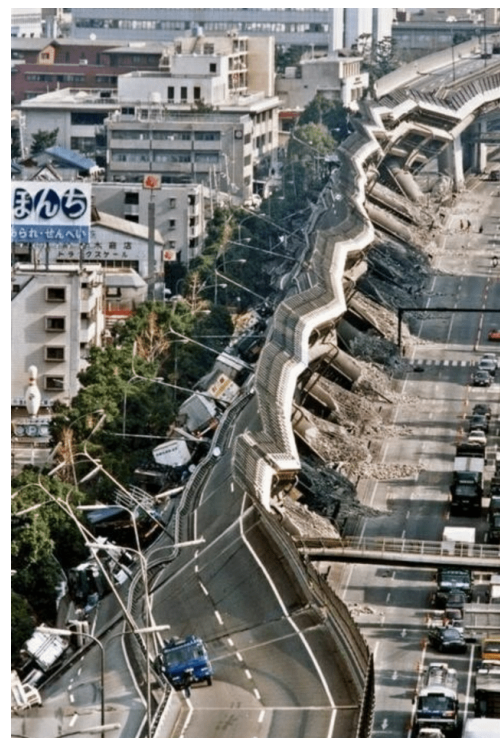
Dégâts de la ville de Kobé
