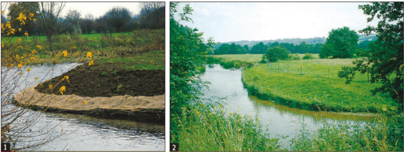
1 a. Une rivière à la fin des travaux d'aménagement de ses berges (1) et deux ans après (2).
